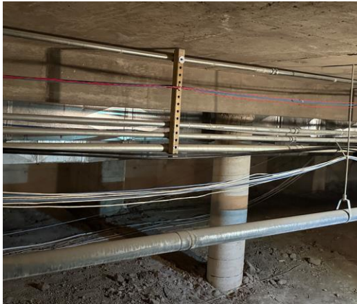
Conduits in Crawlspace
